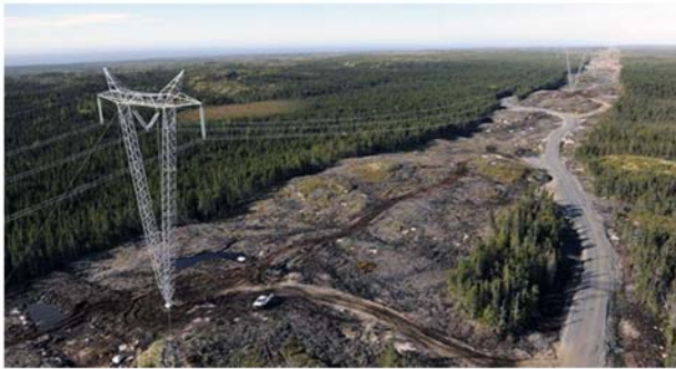
Figure 2. Transmission line from Romaine 2. Source: (Géomatique, Hydro-Québec Équipement 2015; Hydro-Québec n.d.a)
